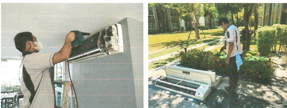
รูปภาพที่ 2.22 การทำความสะอาดเครื่องปรับอากาศ
