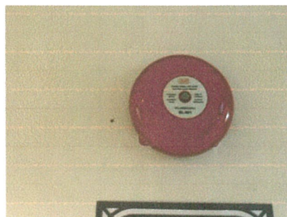
อุปกรณ์ส่งสัญญาณหนีไฟแบบกริ่ง รูปภาพที่ 2.32 ระบบป้องกันและเตือนอัคคีภัย
